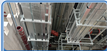
內部裝修及機電安裝
