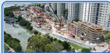
地面出入口及通風樓結構工程
