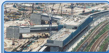
車站主體結構
