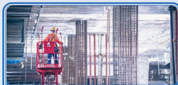
大堂層內部結構工程
