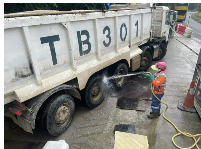
安排泥頭車離開工地前清洗車輪
