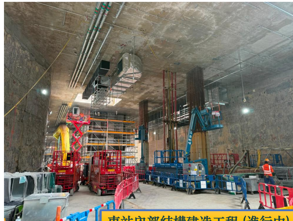
車站內部結構建造工程 (進行中)
