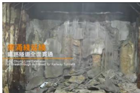
東涌西段隧道貫通
