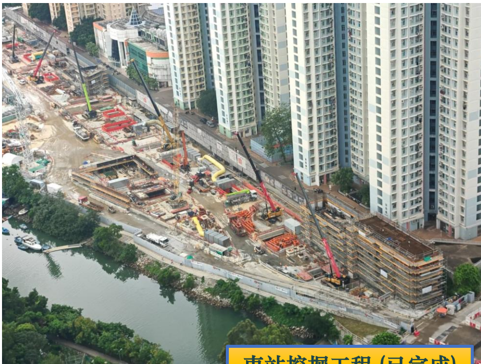
車站挖掘工程 (已完成)
