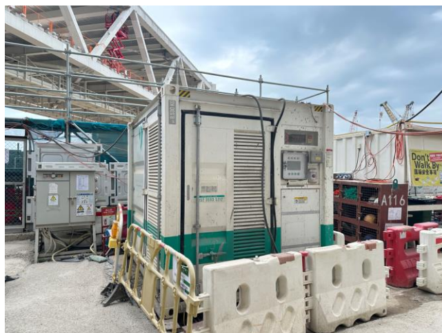
使用流動電源取代發電機
