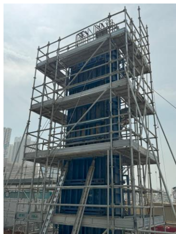
採用可重用金屬板模施工
