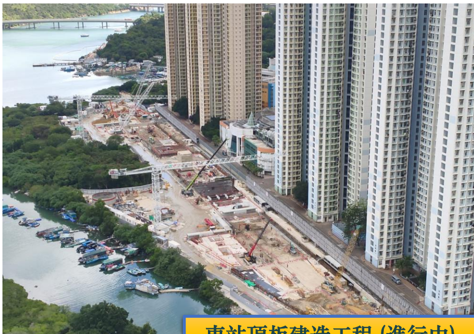
車站頂板建造工程 (進行中)
