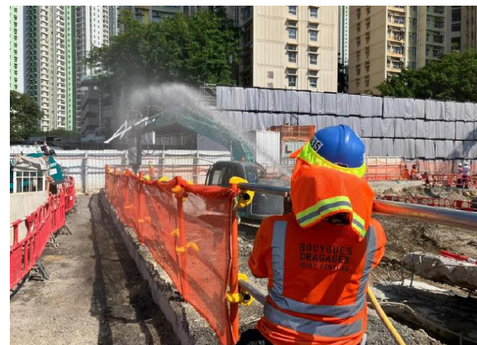
安排工程期間灑水
