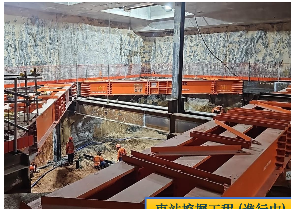
車站挖掘工程 (進行中)
