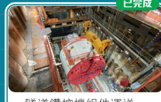
隧道鑽挖機組件運送、組裝及展開隧道建造工程
