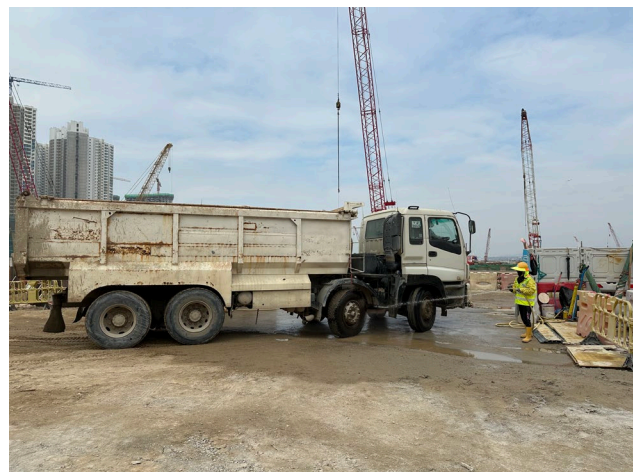
為離開地盤的工程車輛清洗輪軌
