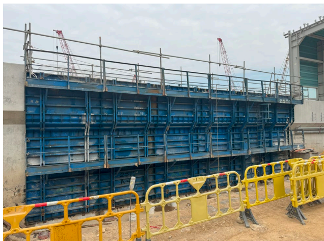
採用可重用金屬板模施工
