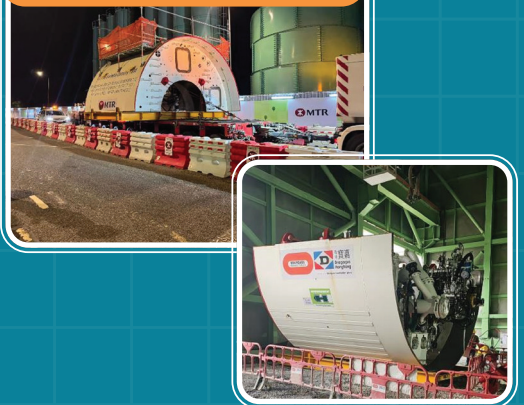
隧道鑽挖機組件運送及組裝
