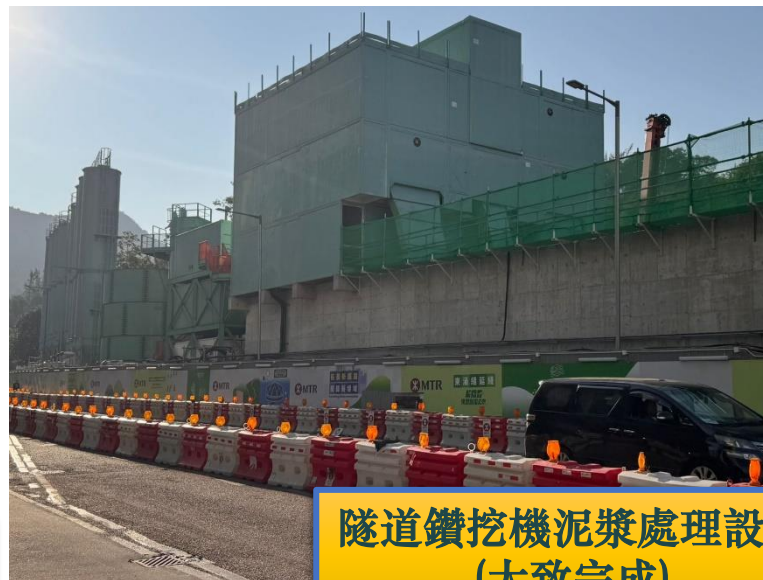
臨時隔音罩建造工程 (已完成)
