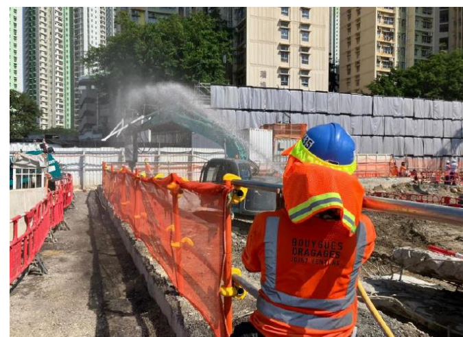
安排工程期間灑水
