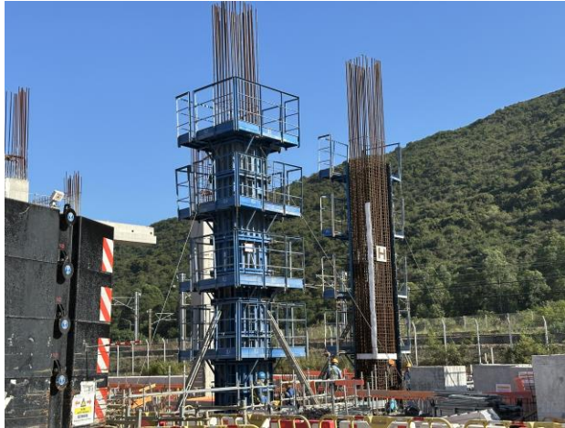
採用可重用金屬板模施工
