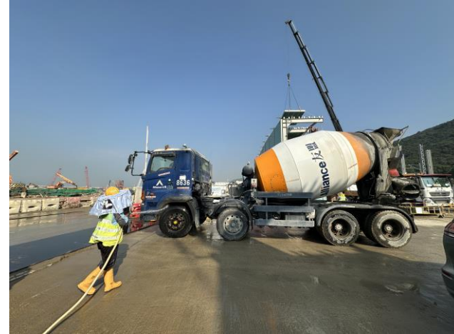
為離開地盤的工程車輛清洗輪軟
