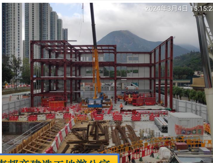
滿東邨旁建造工地辦公室
