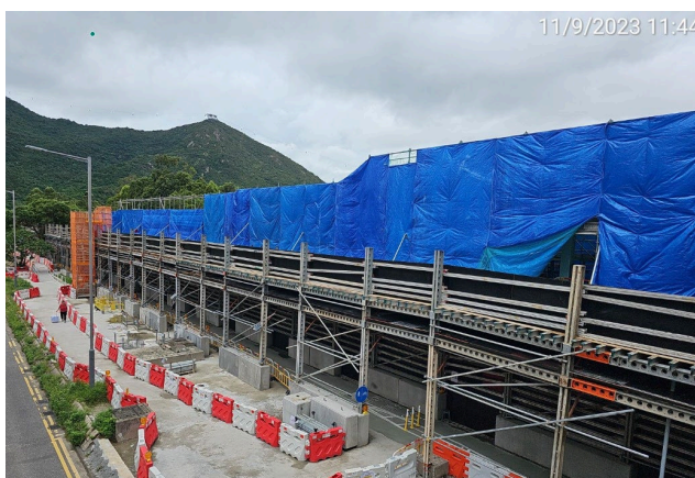
施工範圍設隔音/隔塵布
