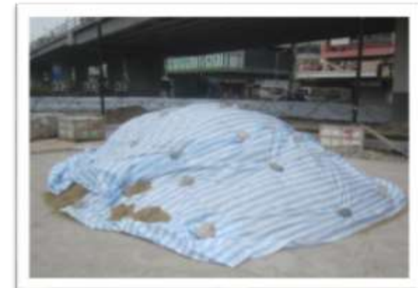
防水布覆蓋存料堆
