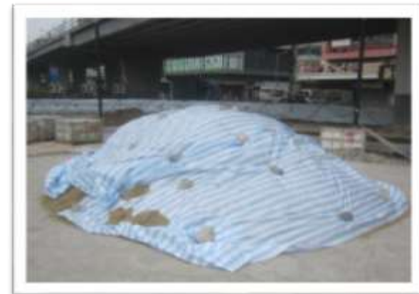
防水布覆蓋存料堆
